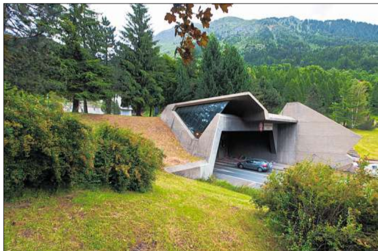
Südportal des Gotthardtunnels bei Airolo.
