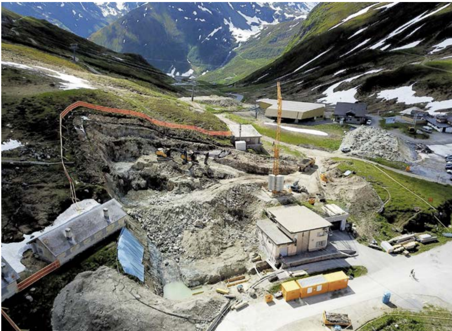
Die Bauzeiten im hochalpinen Raum sind kurz und dauern nur ein paar Monate. Hier die Baustelle Oberalp- pass im Sommer 2018.
